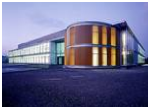
Das neue Science to Business Gebäude in Marl
